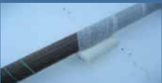
Rivestimento del tubo
